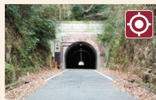
⑥ 峠清水トンネル
