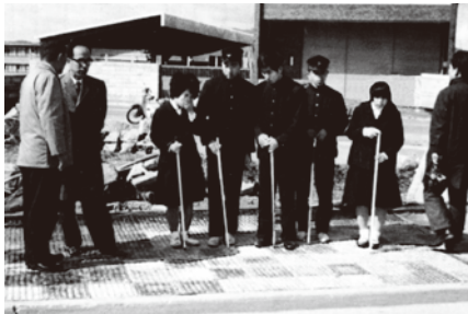
点字ブロック敷設の歩道が完成 盲学校生徒が渡り初め(1967年、岡山市の国道2号) (一財)安全交通試験研究センター提供
